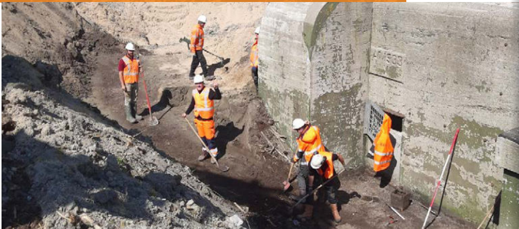
Het vrijleggen van een van de kazematten op de Afsluitdijk bij Kornwerderzand in combinatie met opsporingswerkzaamheden (foto: BAAC).
