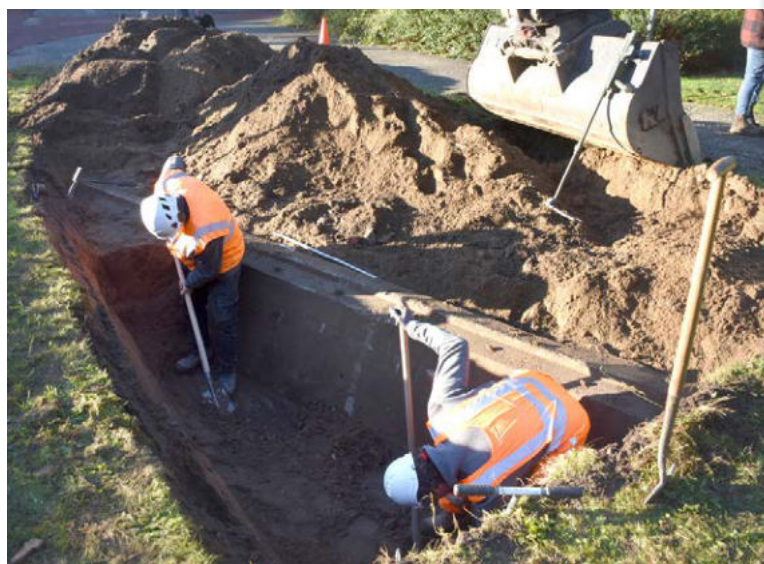
Bij het uitgraven van een boomplantgat aan de Prins Bernhardstraat in Nijmegen onder begeleiding van archeologen en een opsporingsbedrijf is een betonnen schuilloopgraaf voor de burgerbevolking aangetroffen (foto: Gemeente Nijmegen).
