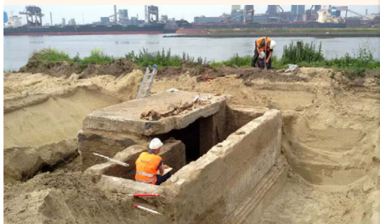
Het documenteren van een Duitse opslagbunker voor munitie op het Middensluisland bij IJmuiden (foto: Vestigia).
