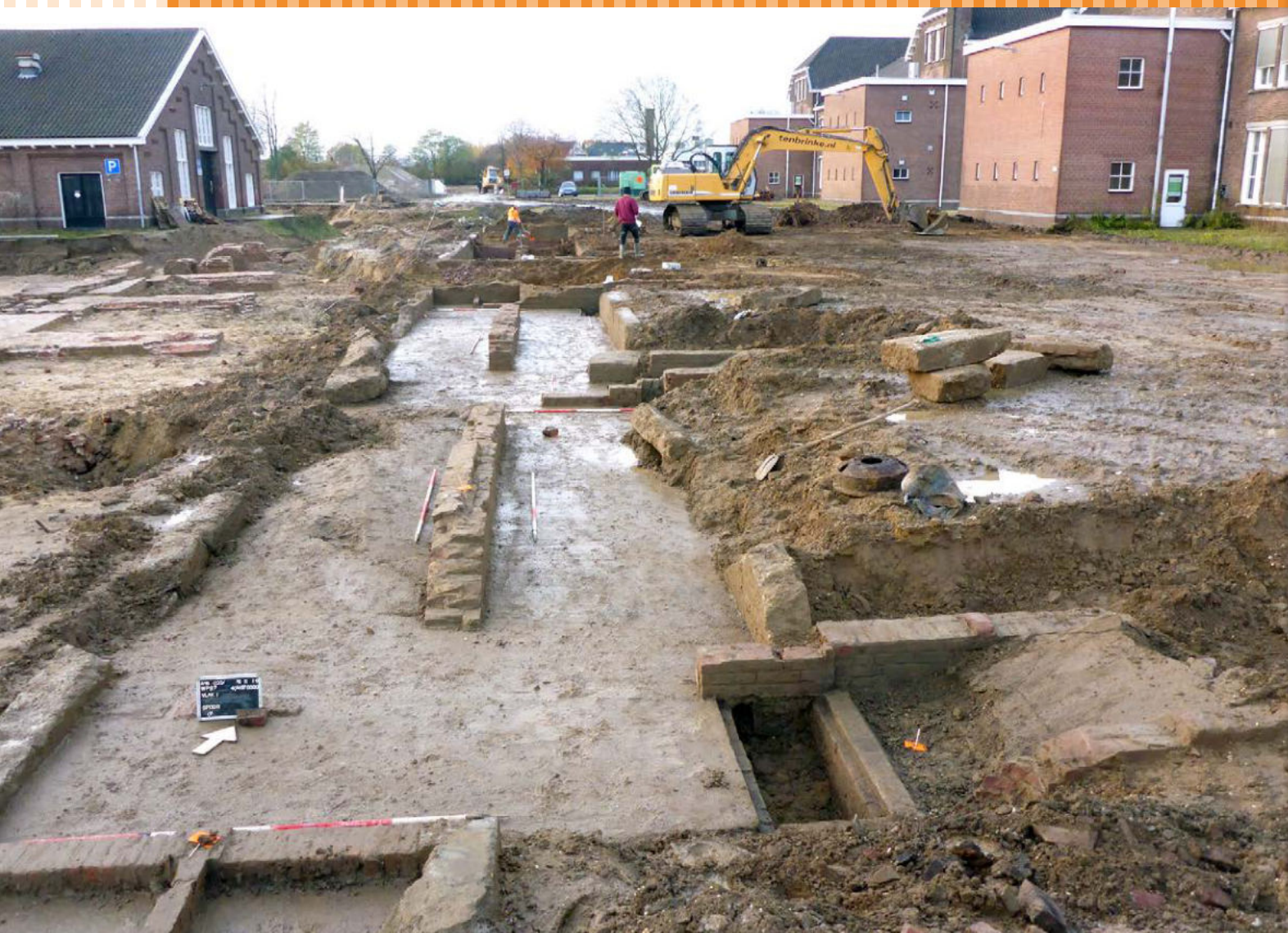
Het vrijleggen van de resten een Duitse schuilkelder op het kazerneterrein in Blerick (Foto: BAAC).
