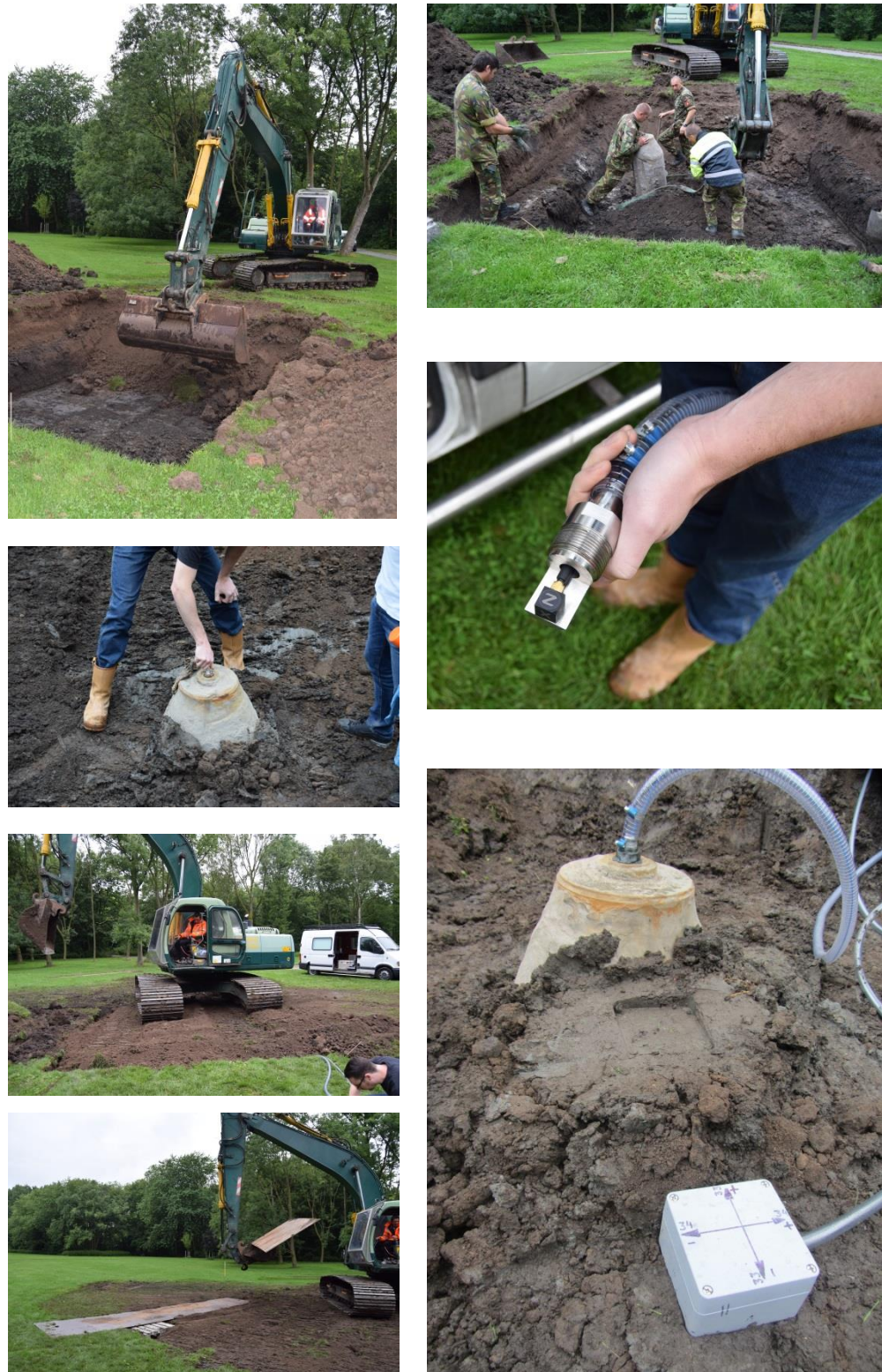
Figuur 21 Locatie Zestienhoven: grondverzet (linksboven); plaatsing bom verticaal (rechtsboven); bevestigen versnellingsopnemer op dummy ontsteker (rechtsmidden); indraaien dummy ontsteker in neus fuze pocket (links 2 e van de boven); plaatsing versnellingsopnemers in behuizing naast het bomlichaam (rechtsonder); verdichten ("aanrupsen") van de grond (links 3 e van boven); afdekking met rijplaten (linksonder).
